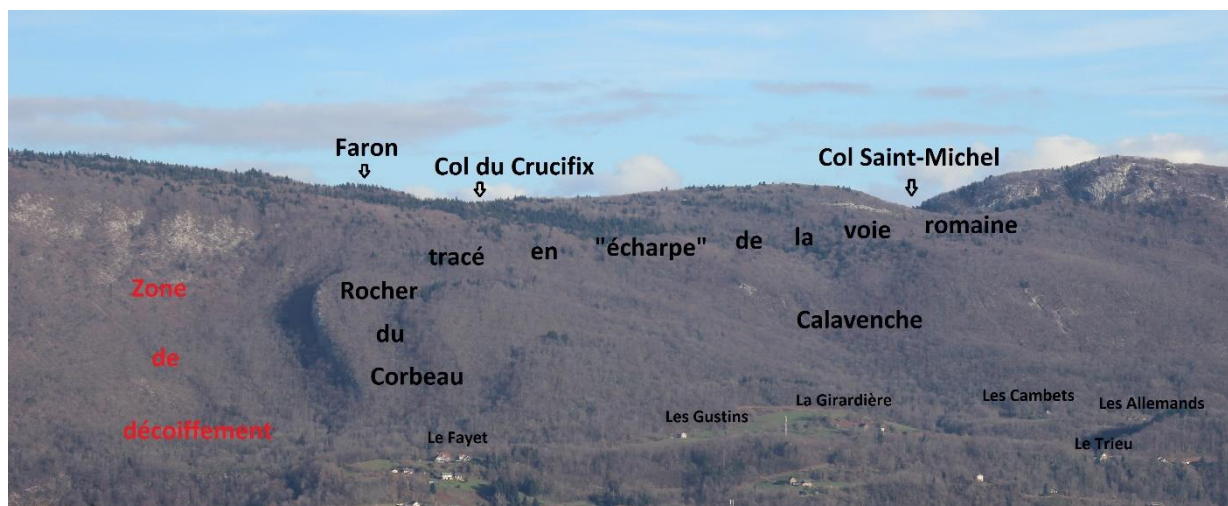
Fig. 12 – « Décoiffement » et glissements du versant occidental de l'Epine.
