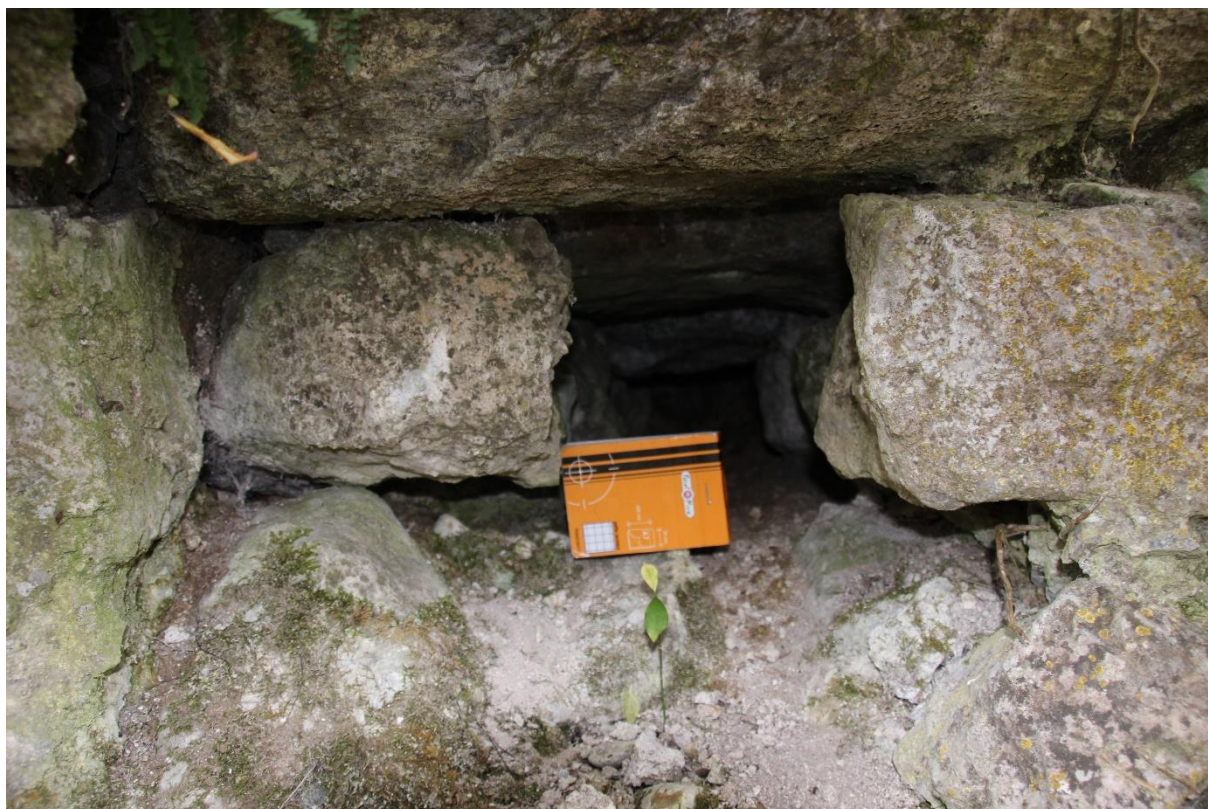
Fig. 4 – Vue interne d'une « percée » de faisceau. N.B. : 1) vue depuis l'extérieur vers l'intérieur, 2) calepin de 7 x 10 cm donnant l'échelle, et 3) la dégradation du parement extérieur semble avoir constitué, à gauche, et au-dessous, une fictive ébrasure.
