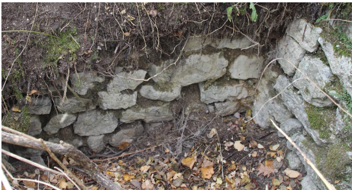
Fig. 3 – Appareillage interne de la tour du Miradou
