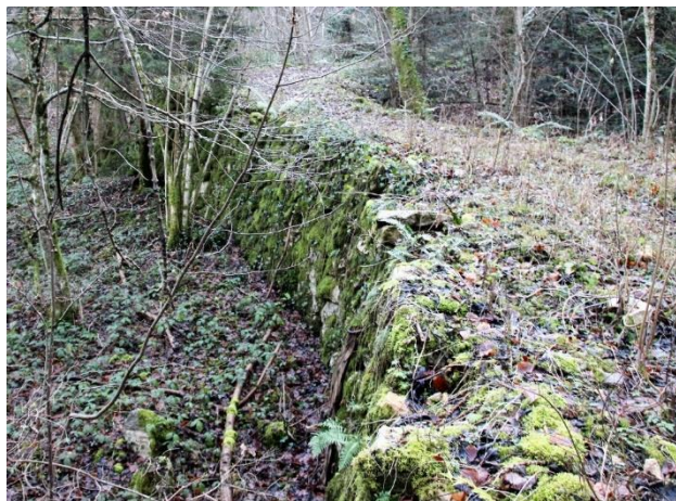
Fig. 8 – Infrastructures de la voie romaine sous la carrière de marbre gris de Vimines
