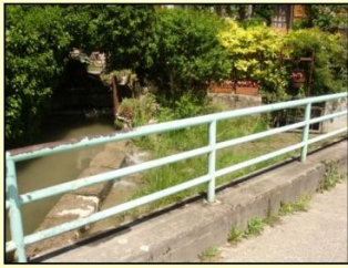
Rue Plaisance, le canal et, à droite, le trop plein, autrefois canal secondaire de dérivation.
