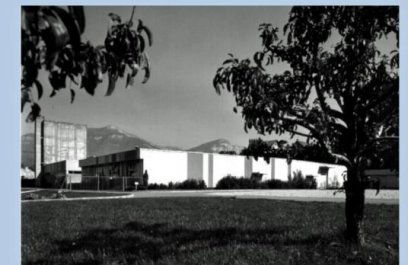
L'usine de la Revériaz.
